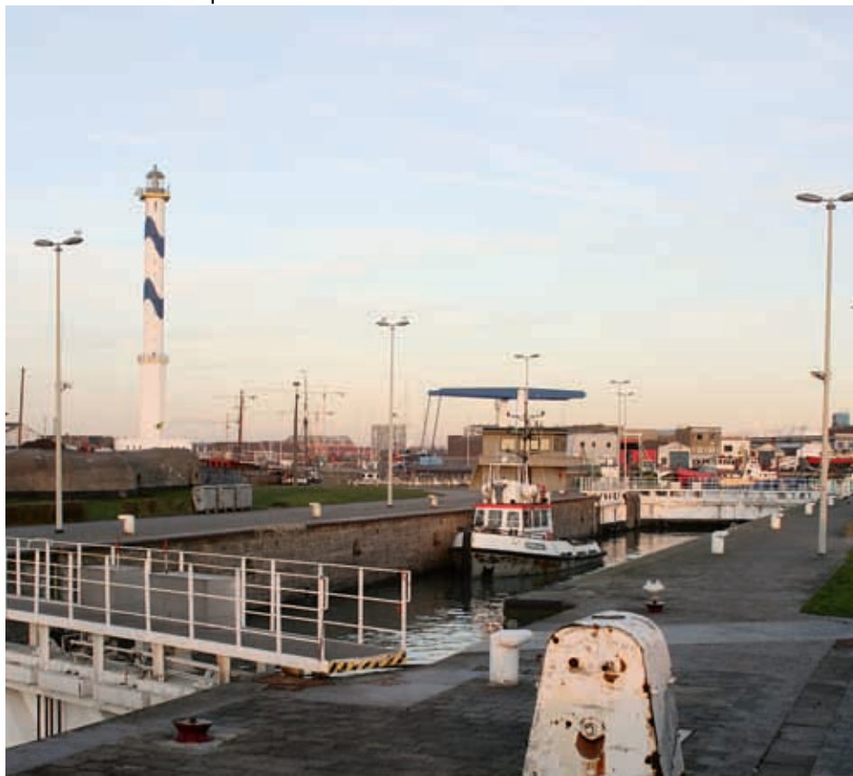
De Visserijsluis, die het Visserijdok te Oostende verbindt met de havengeul, is uitgerust met twee paar puntdeuren. Door deze sluis is de achterliggende vissershaven getijvrij (VL)
