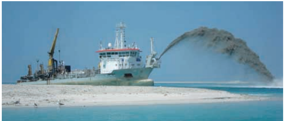
De rainbowtechniek: een baggerschip sproeit het zand-watermengsel rechtstreeks op de plaats van bestemming (TC)
