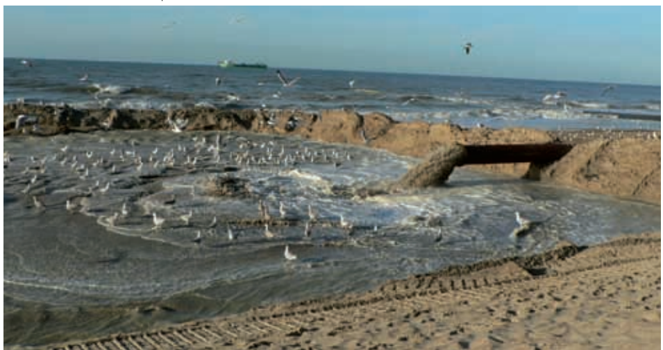
Opspuiting waarbij de sleephopperzuiger ter hoogte van het aankoppelpunt op zee het baggermengsel van zand en water door de persbuis stuwt (AK)
