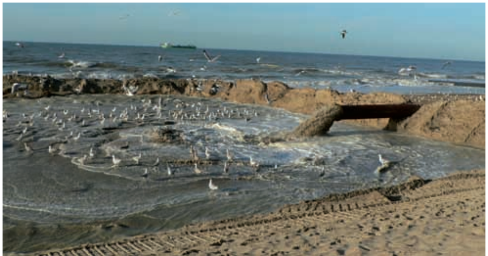
Opspuiting waarbij de sleepopperzuiger ter hoogte van het aankoppelpunt op zee het baggermengsel van zand en water door de persbuis stuwt (AK)
