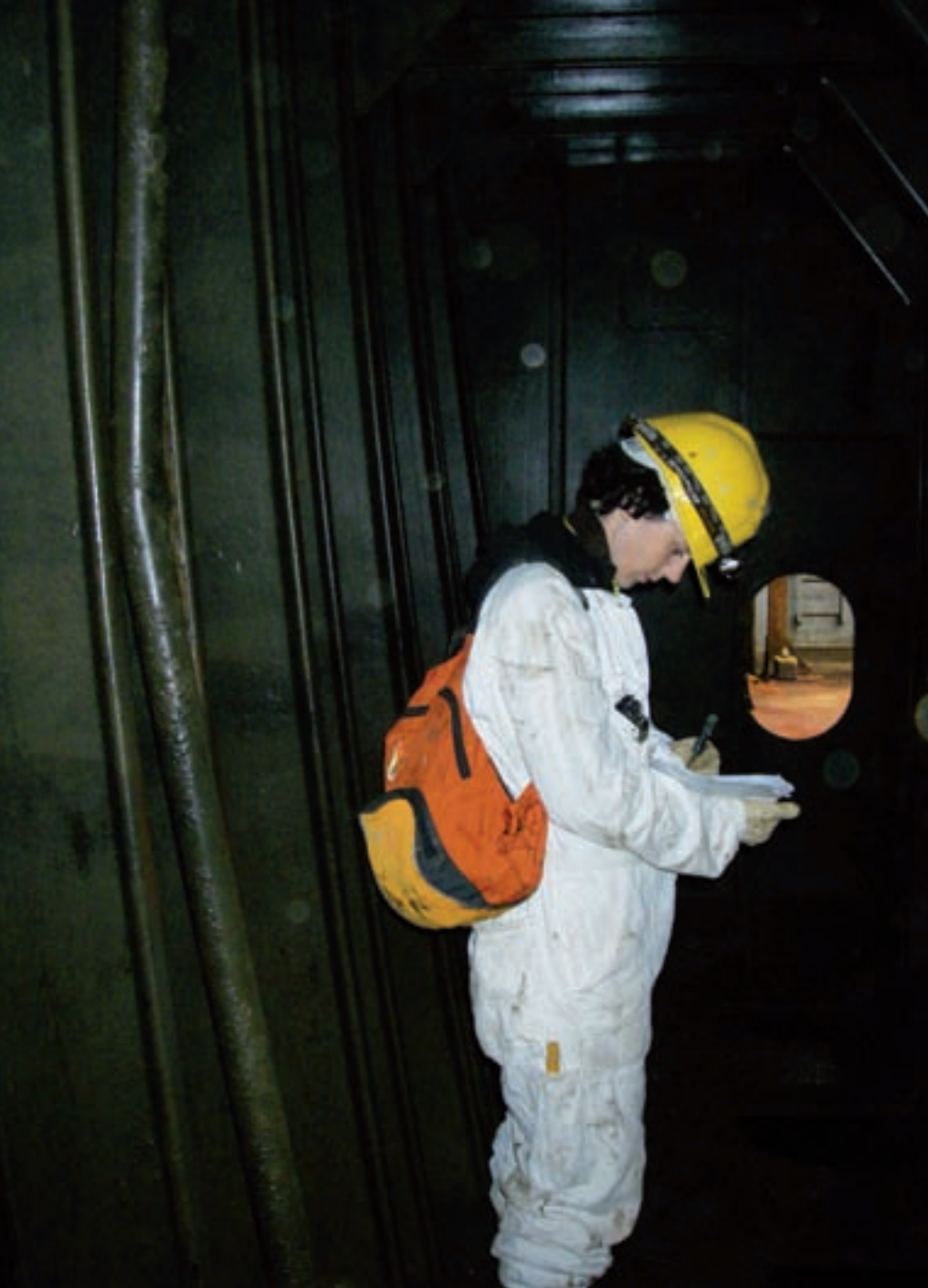
■ Zicht op een moderne ballasttank, ter illustratie van de vaak moeilijke toegankelijkheid en de complexe opbouw. De openingen meten ongeveer 70 bij 100 cm (HZS)
