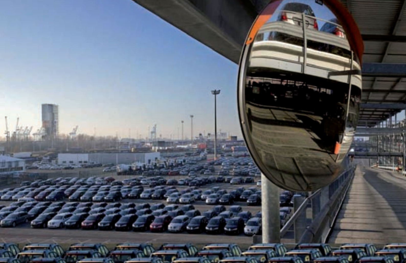
■ De verdiepinggarage voor auto's op de Britanniaterminal te Zeebrugge (MD)
