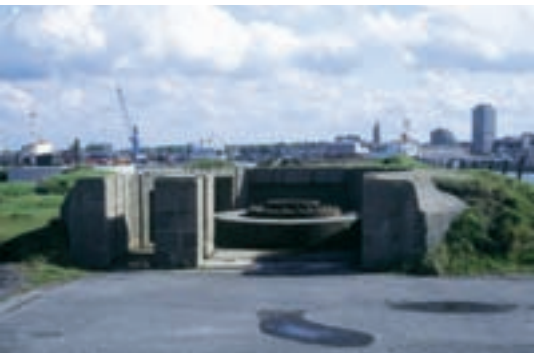
■ De kustbatterij 'Halve Maan' op de Oostendse Oosteroever is een mooi voorbeeld van een Duitse FLAK-batterij uit de Tweede Wereldoorlog. Ook tijdens de Eerste Wereldoorlog stond op deze zeer strategische plek bij de havengeul al een Duitse batterij (MR)
