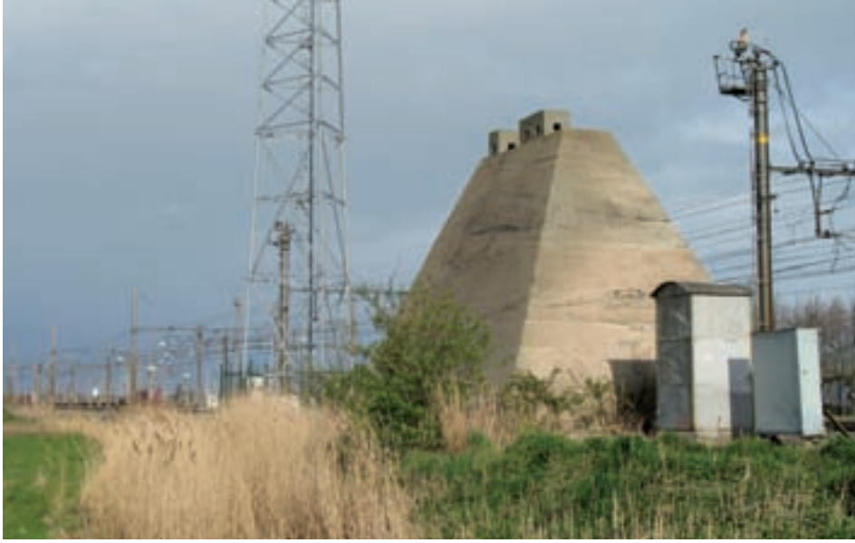
■ De Duitse personenschuilbunker in Zandvoorde is nog steeds een merkwaardige verschijning naast de spoorlijn Brugge-Oostende. Het spitse dak was bedoeld om de bommen te doen afketsen (MR)
