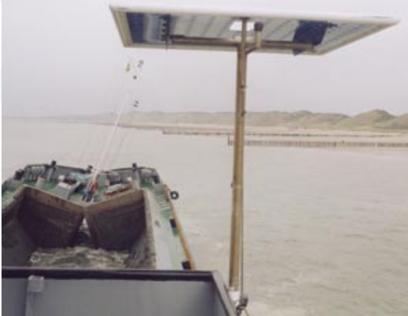
Het aanbrengen van de suppletie in het Oostgat met een zogenaamde splijtbak, die aan de onderkant zijn lading lost.
