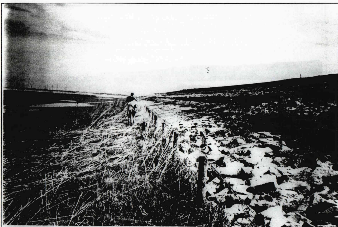
Aangebrachte verdediging op de zeedijk, met links in het schor duidelijk kale plekken
