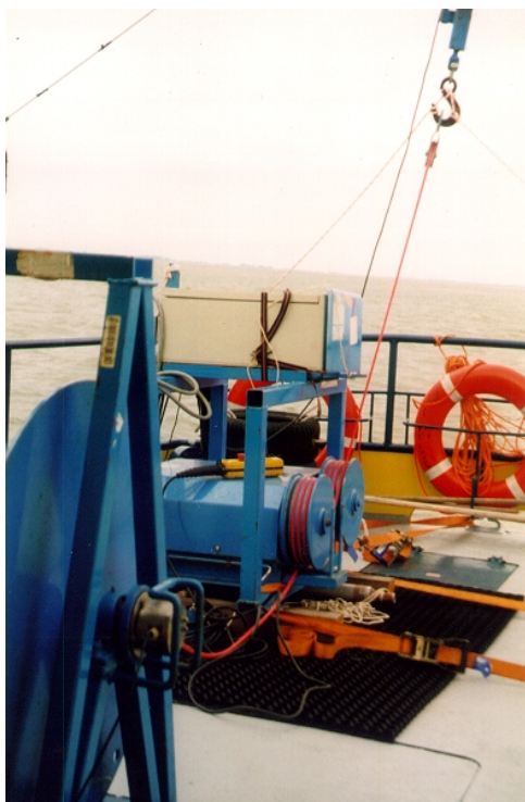
Figuur 6: Opstelling pully en lier aan dek van de "Kalo"
