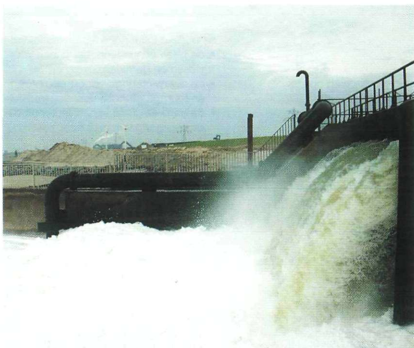
38. De koelwaterlozing bij de kerncentrale te Borssele beïnvloedt de watertemperatuur.
