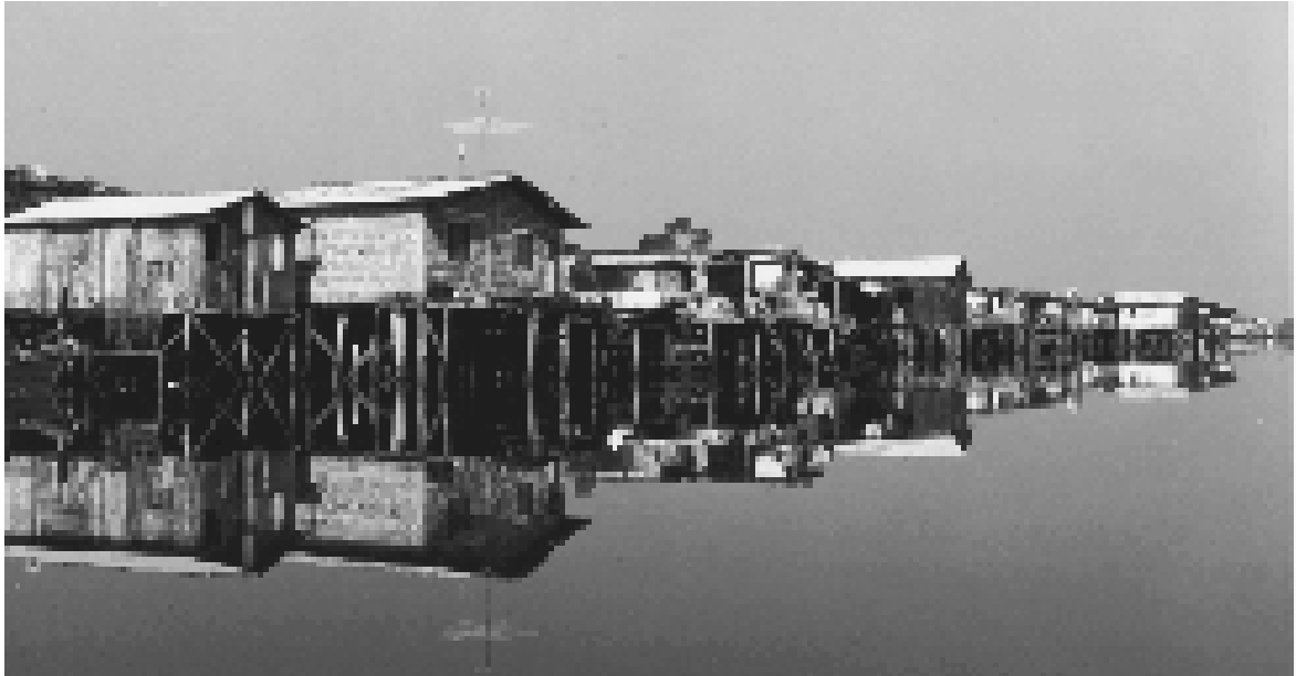
Figuur 2-4 Paalwoningen in Brazilië
