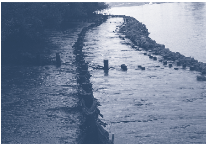
Alternatieve schorrandverdediging met terrasbouw in wilgenlechtwerk gevlochten tussen perkoenpalen.
