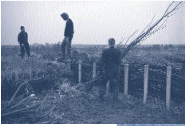
Boven: Aanleg rijshouten en wiepen-dammen in 1992
