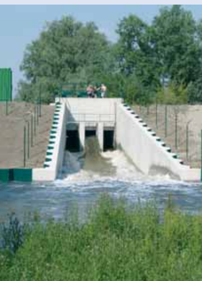
De sluis van dichtbij
