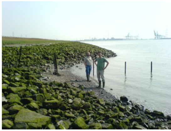
Hoogteverschil schor en slik. Let op de hoogte van de verdediging, vergelijk met lengte personen.
