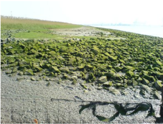
Schorrandverdediging Galgeschoor ter hoogte van de zwaaizone (foto's Mindert de Vries)
