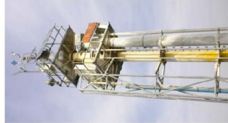
Meetpaal bij Brouwershavense gat 2
