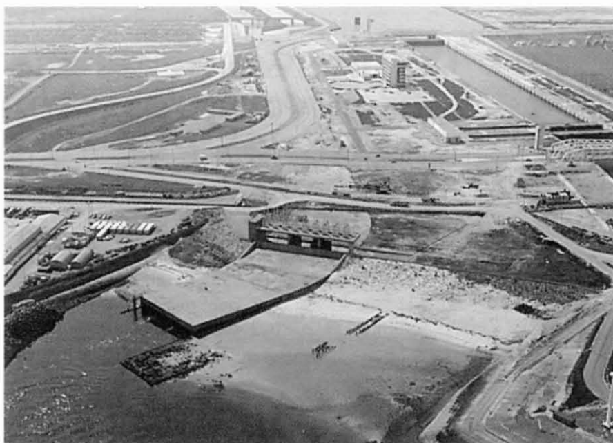
Uitwateringssluizen te Zeebrugge-Heist.
