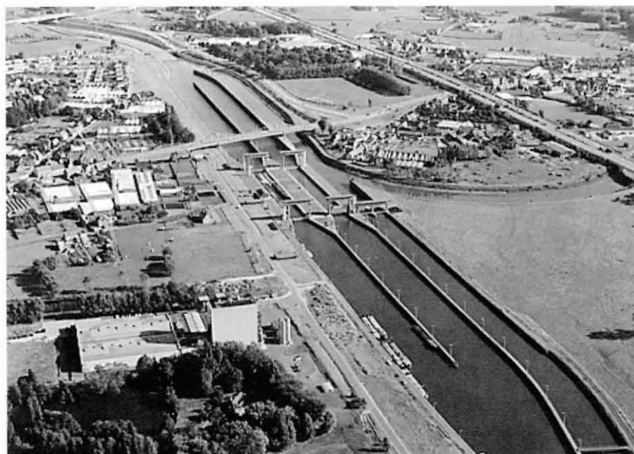
Sluizencomplex te Merelbeke (E2-B2 op kaart 2).
