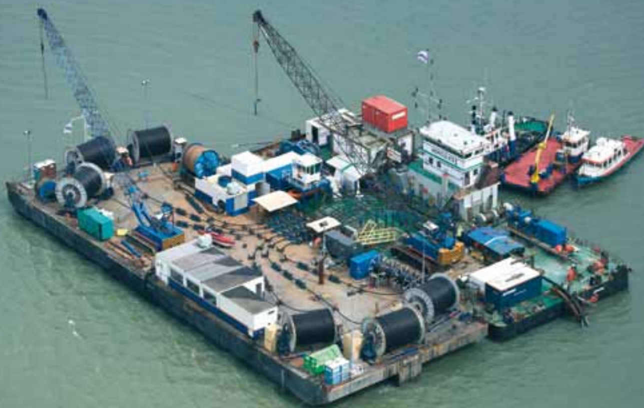
De leg-unit waarmee Delta in 2008 de 150 kV kabel in de Westerschelde heeft gelegd
