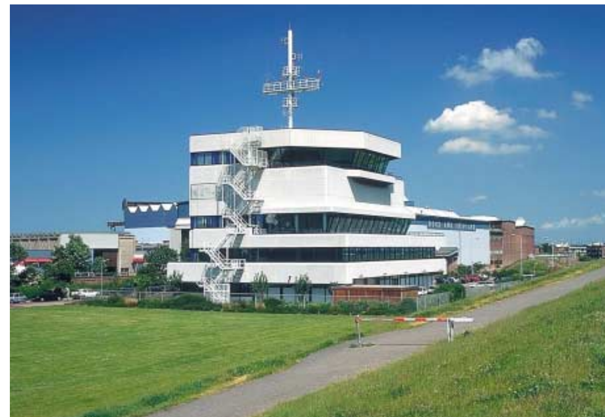
Vanuit het Schelde Coördinatie Centrum in Vlissingen worden de nautische opleidingen van Rijks-waterstaat Directie Zeeland gecoördineerd
