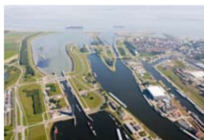
De haven van Terneuzen gezien vanuit de lucht
