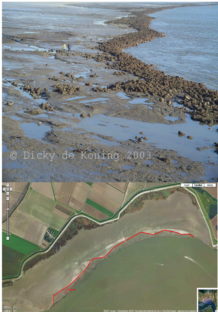
Fig. 9 Geulwandverdediging Nauw van Bath; De rode lijn is tot waar het veen aan het oppervlak ligt. Fotopunt is ook aangegeven (vanaf een paal, 10m hoog, genomen). De bestorting is op de laagwaterlijn nog net waarneembaar.
