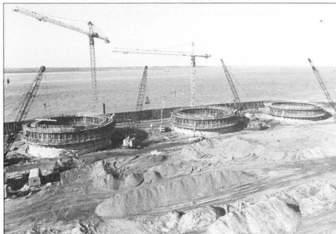
Foto 6: inwendige ontgraving binnen in de caissons.
