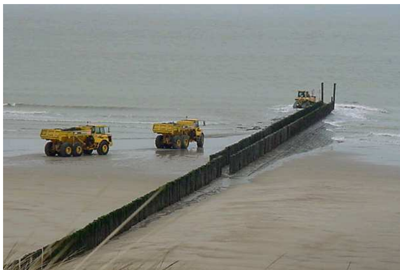
Uitvoering bestortingen aan strandhoofden
