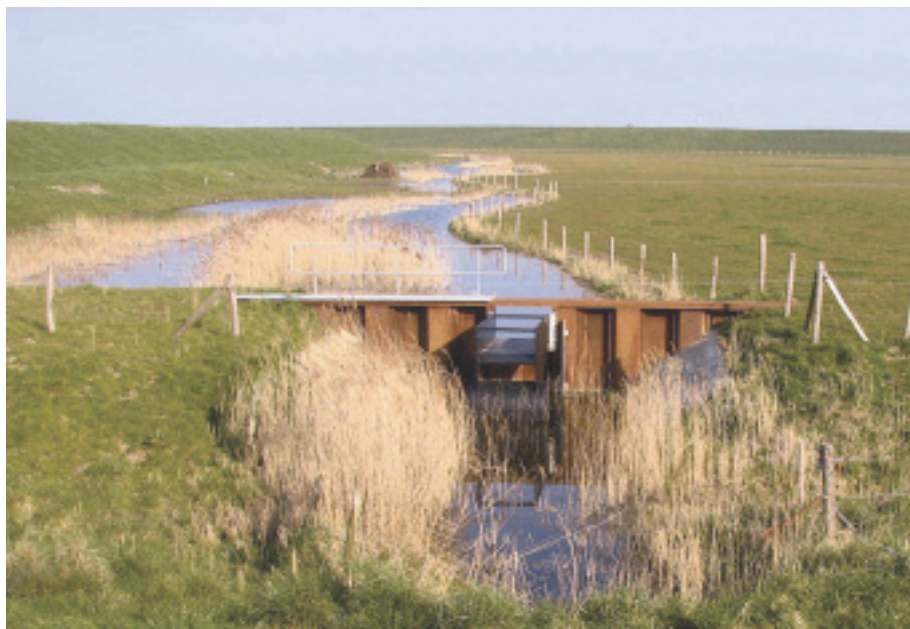
Regelen van de waterhuishouding met een stuw
