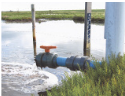
Via een kwelbuis wordt de kwelstroom in het natuurgebied versterkt
