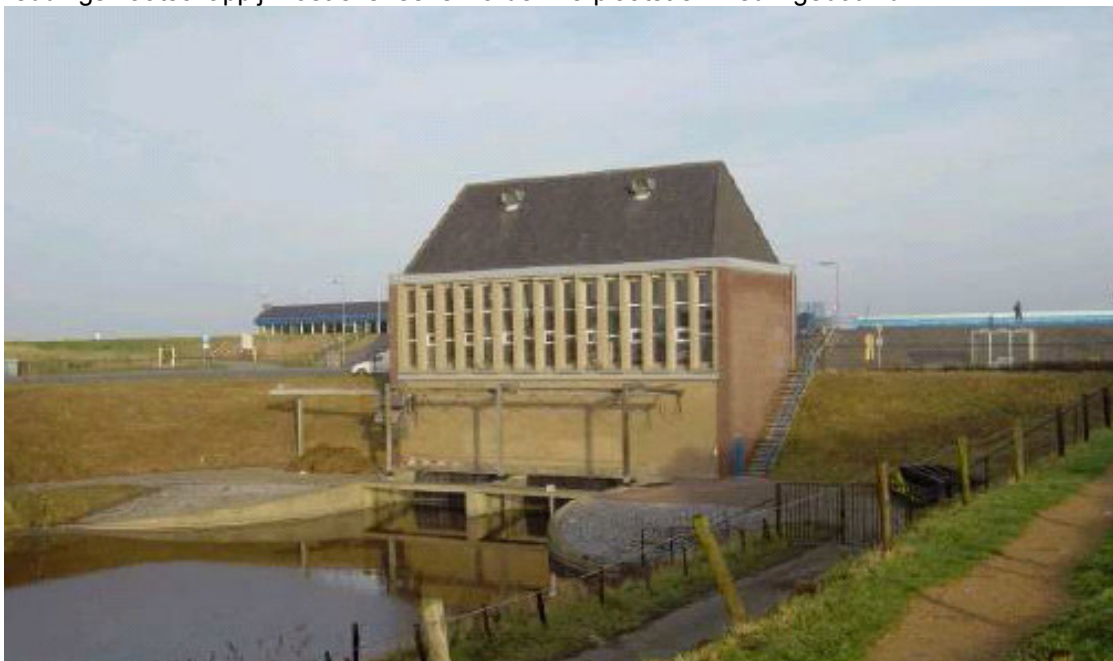
Foto Het gemaal te Cadzand-Bad
