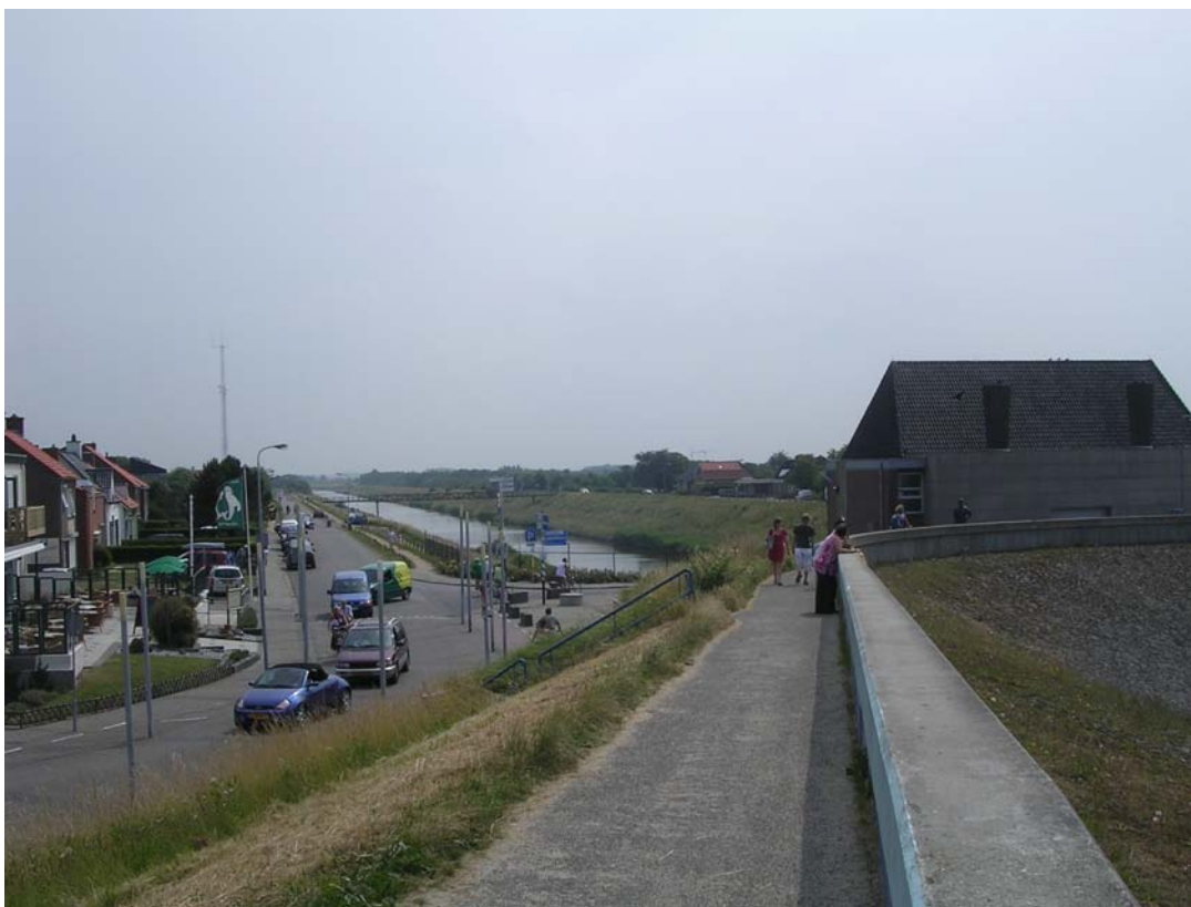
Foto De oostelijke zijde van de gemaalmonding is een zwakke maar ook krappe plek in de primaire kering
