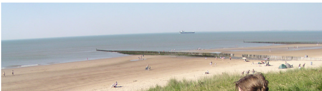
Foto Strand en paalhoofden bij Cadzand-Bad
