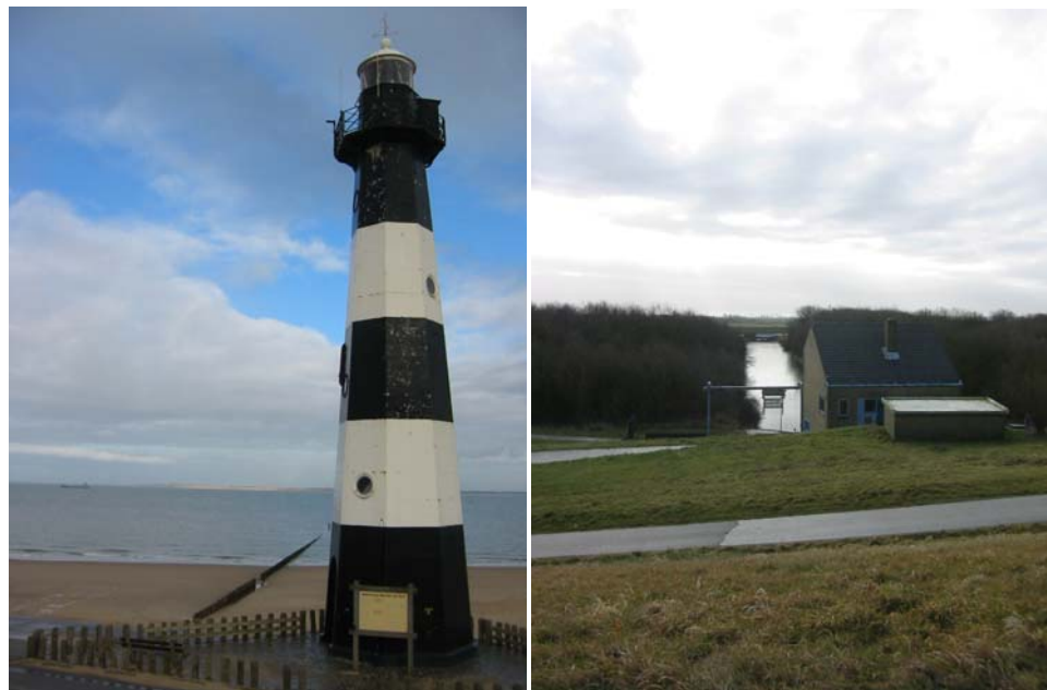
Vuurtoren en uitlaatwerk Nieuwsluis
