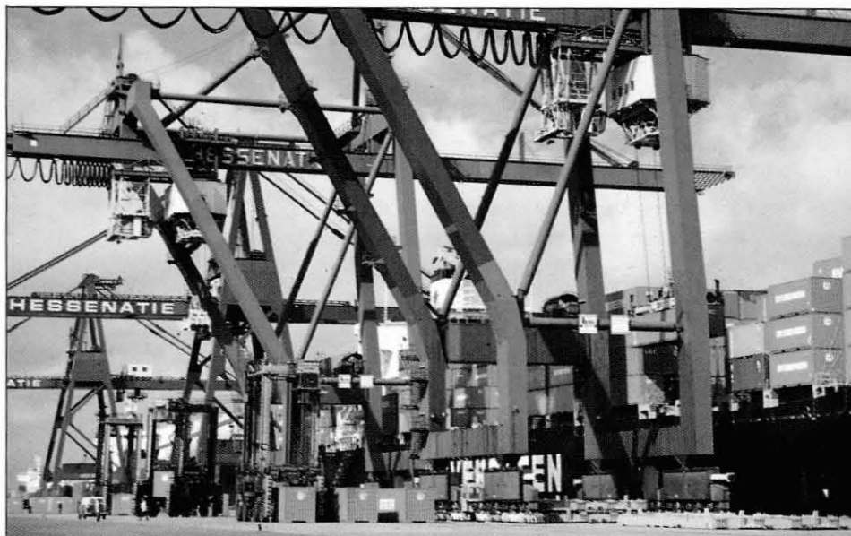
Containerlaadbruggen op de Hessenatie-terminal aan het Delwaiedok.
