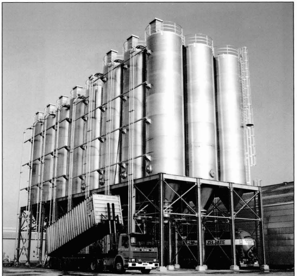
Aluminium silo's voor de opslag van kunststoffen.
