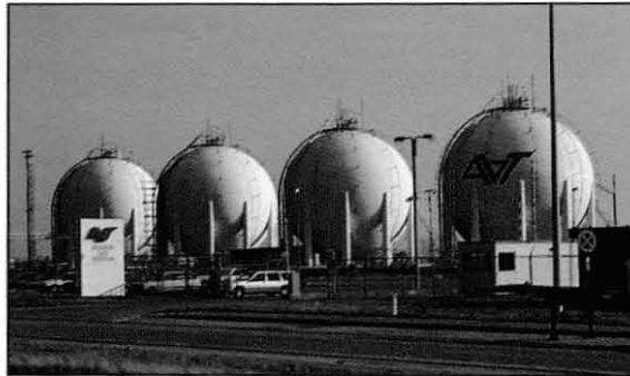
Installaties van Antwerp Gas Terminal – AGT (links), Gamatex (midden) en General Tank Storage (hieronder).
