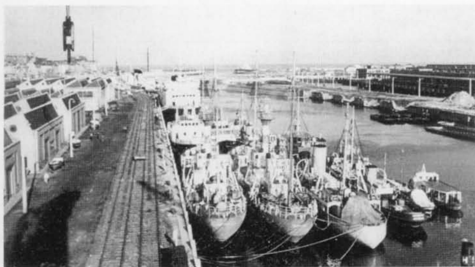
Fig. nr. 134. Haven Oostende 1955. Zicht op het Zeewezendok dat reeds terug in gebruik is na gedeeltelijk herstel van de verwoestingen van W.O. 2. Rechts de oostelijke oever van het dok waar de kaaimuur nog niet volledig hersteld is. Men bemerkt nog de kraters geslagen door het dynamiteren door de demolitieploeg van de terugtrekkende Duitsers begin september 1944. De werkhuizen zijn reeds herbouwd volgens de nieuwe lay-out van de site.
