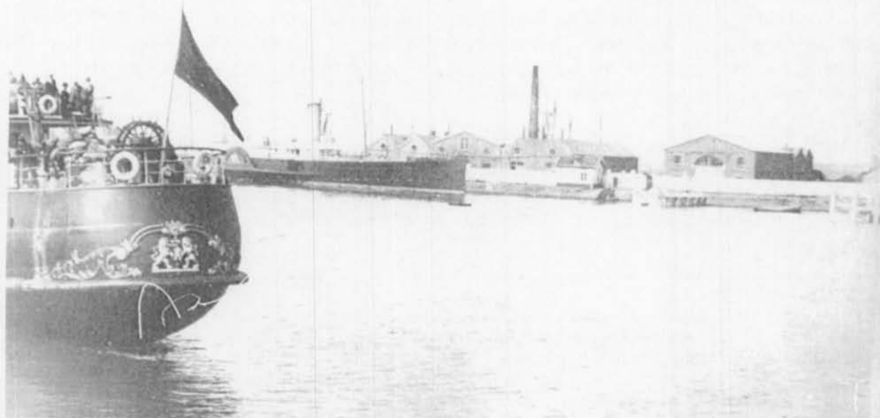
Fig. nr. 131. Haven Oostende omstreeks 1913. Zicht op de oosteroever en de werkhuizen van het Zeewezen. Bemerkt de omheiningmuur van de werkhuizensite met het wachthuisje aan het toegangspoortje dat toegang verleent tot de aanlegposten. Van links naar rechts onderscheiden we: de smidse en de ketelmakerij, de paswerkerij en een magazijn. Op de voorgrond het achterschip van een turbinepakketboot. Bemerkt het groot heraldisch schild op de achtersteven.
