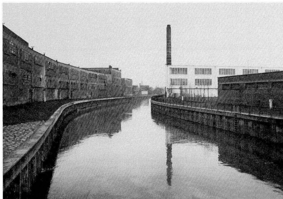
FOTO 3. Zenne — Profielverruiming afwaarts de Sluisstraatbrug te Vilvoorde.
