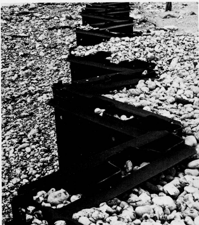
Fig. 1. - Cap de la Heve: 1964 Epis en «zig-zag» arrêtant le cheminement littoral. Entreprise Courbot.
