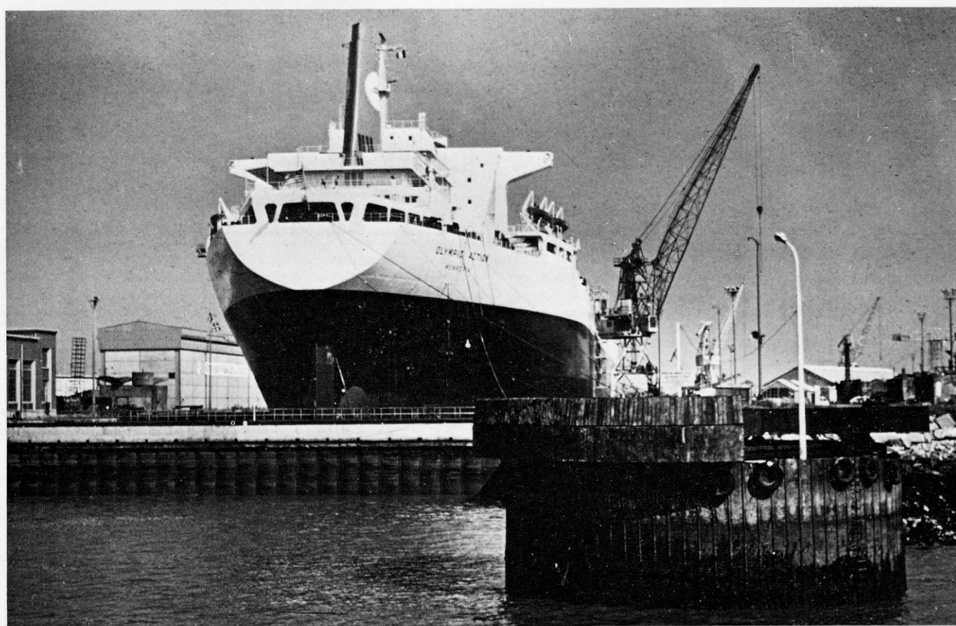
Fig. 3. - Saint-Nazaire: 1966. Duc d'Albe massif d'accostage constitué par un gabion de pal-planches plates. L'amortisseur est constitué par une culasse fixée à des blocs de caoutchouc travaillant en cisaillement horizontal. Entreprise G.T.M.
