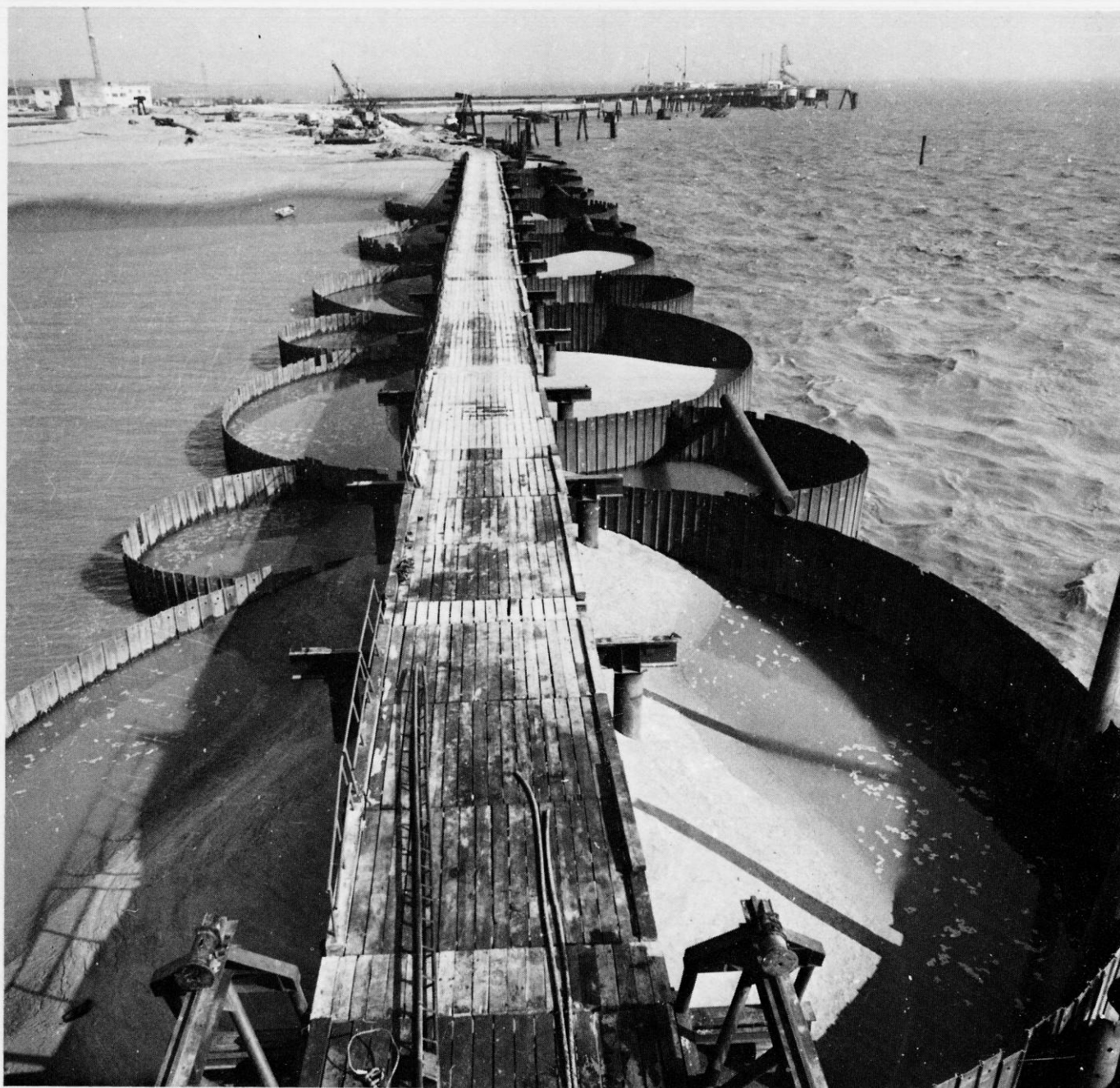
Fig. 27. - Le Verdon - Poste à quai - digue amont: 1976. Gabions circulaires. Exécution en site nautique à l'avancement. Le remblaiement des cellules est effectué par camions. Le marnage favorise la consolidation du massif interne. Le couron- nement et les longrines sous les appareils de manutention sont supportés par des pieux. Les palplanches plates des arcs fron- taux sont du type Rombas 400 g de 400 t/ml de résistance au dégrafage. Entreprise Dodin.
