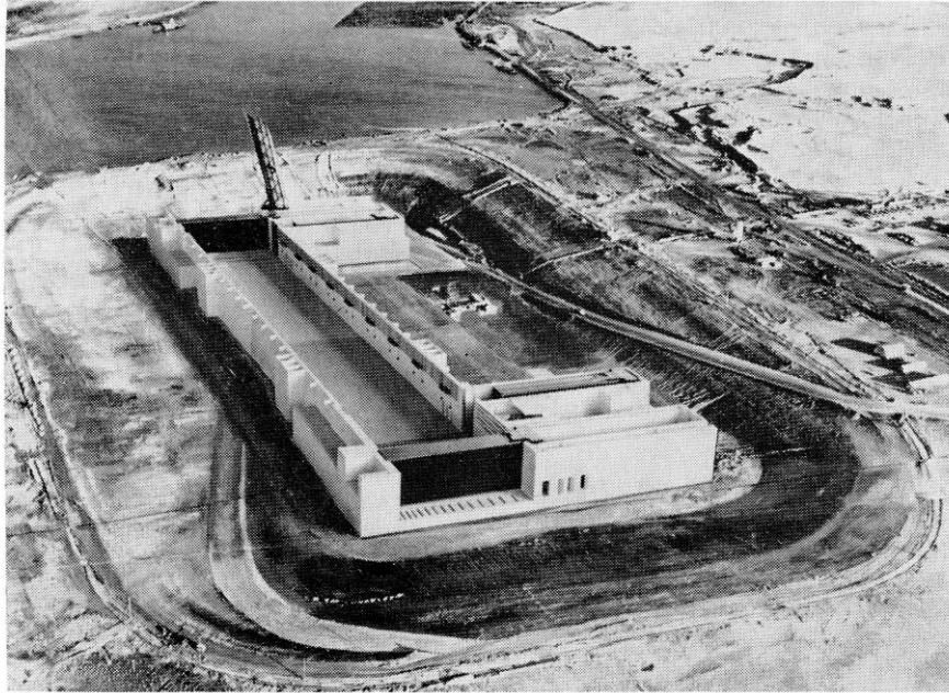
Photo-montage représentant l'écluse telle qu'elle a été construite dans la fouille asséchée.
