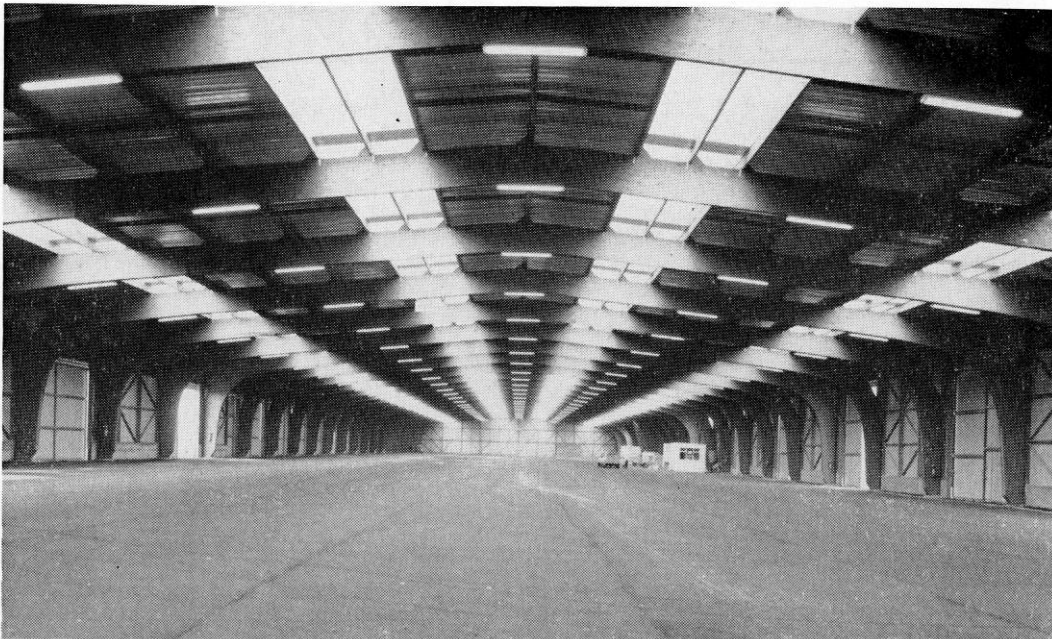
Intérieur du nouveau hangar en charpente lamellée collée pour le dépôtage et le repotage des containers.
