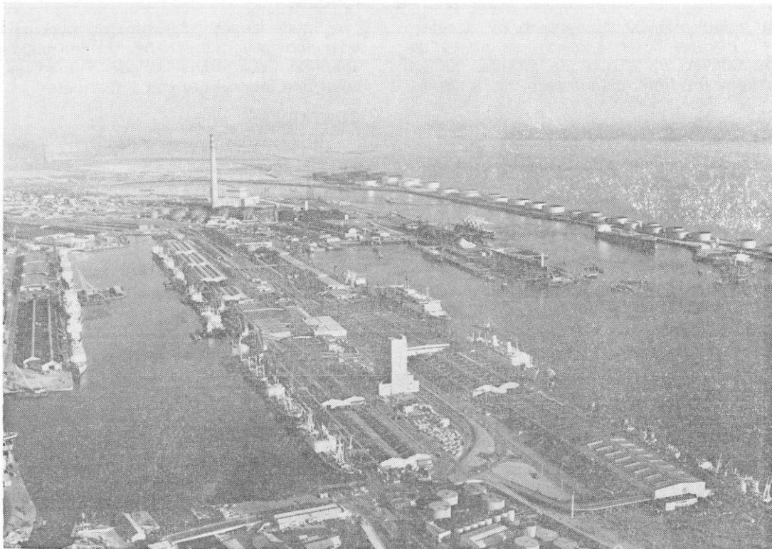
Vue aérienne des bassins BELLOT et Théophile DUCROCQ avec au 1 er plan la 1 re tranche du Silo. (Photo prise en 1970).
