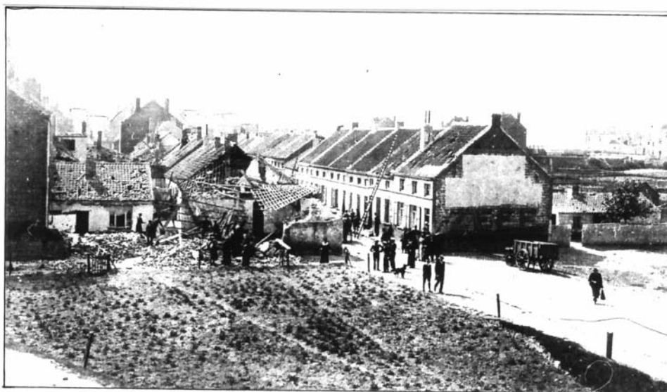
Zicht op de getroffen huizen in de Stokerstraat.
