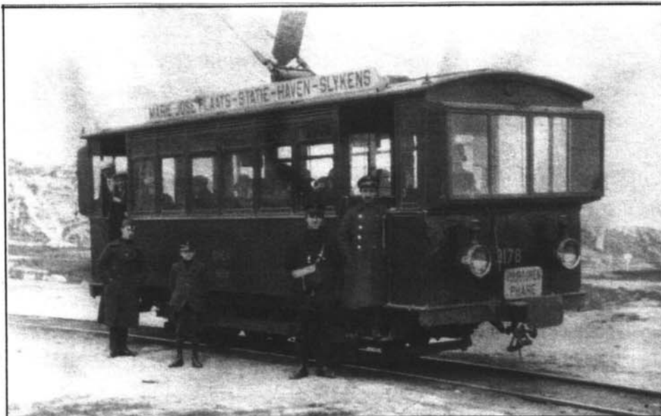
De tram die vanaf september 1903 de verbinding verzekerde tussen de oude Vuurtorenwijk en Oostende-stad. Foto ca. 1930.
