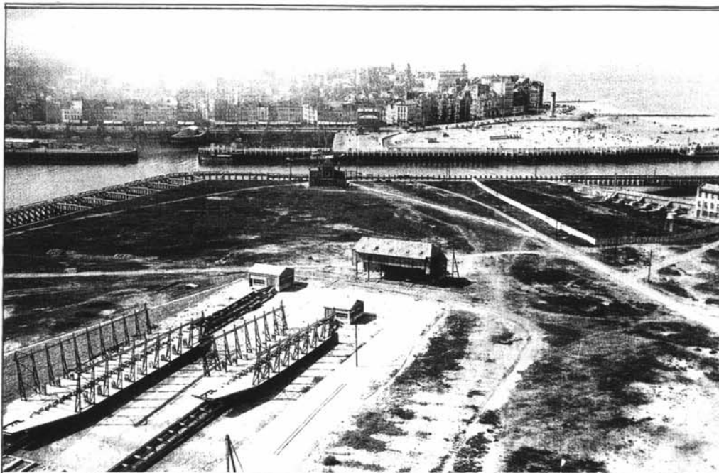
De eerste 'Slipway' gebouwd 1930. Ze werd vervangen door een nieuwe scheepshelling in 1972. Het dienstgebouw midden in beeld werd eveneens vervangen door een aangepaste nieuwbouw in 1977. Rechts in beeld de Leopoldsluis. In het achterplan tegen de havengeul het afgebroken quarantainegebouw waar goederen uit landen waar besmettelijke ziekten heersten preventief ontsmet werden. Foto circa 1930.
