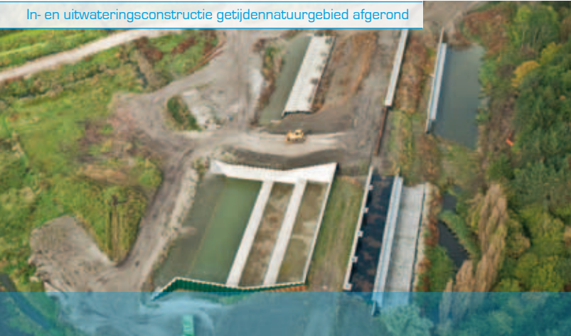
In- en uitwateringsconstructie getijdennatuurgebied afgerond
