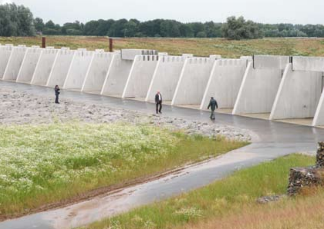
Hondsbroeksche Pleij, regelwerk in de hoogwatergeul.
