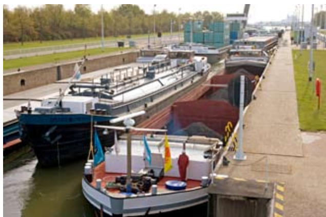
Opstellen van de sluis
