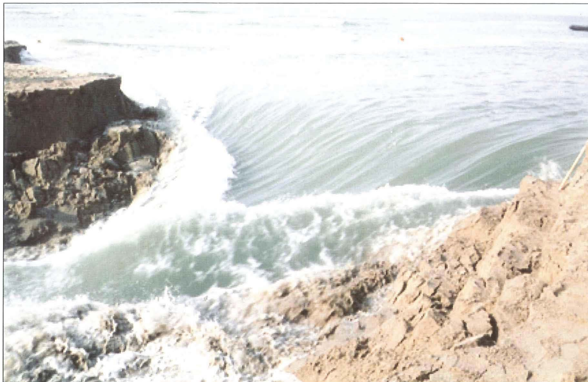
Figuur 5 Verdieping van de bres in fase 3
