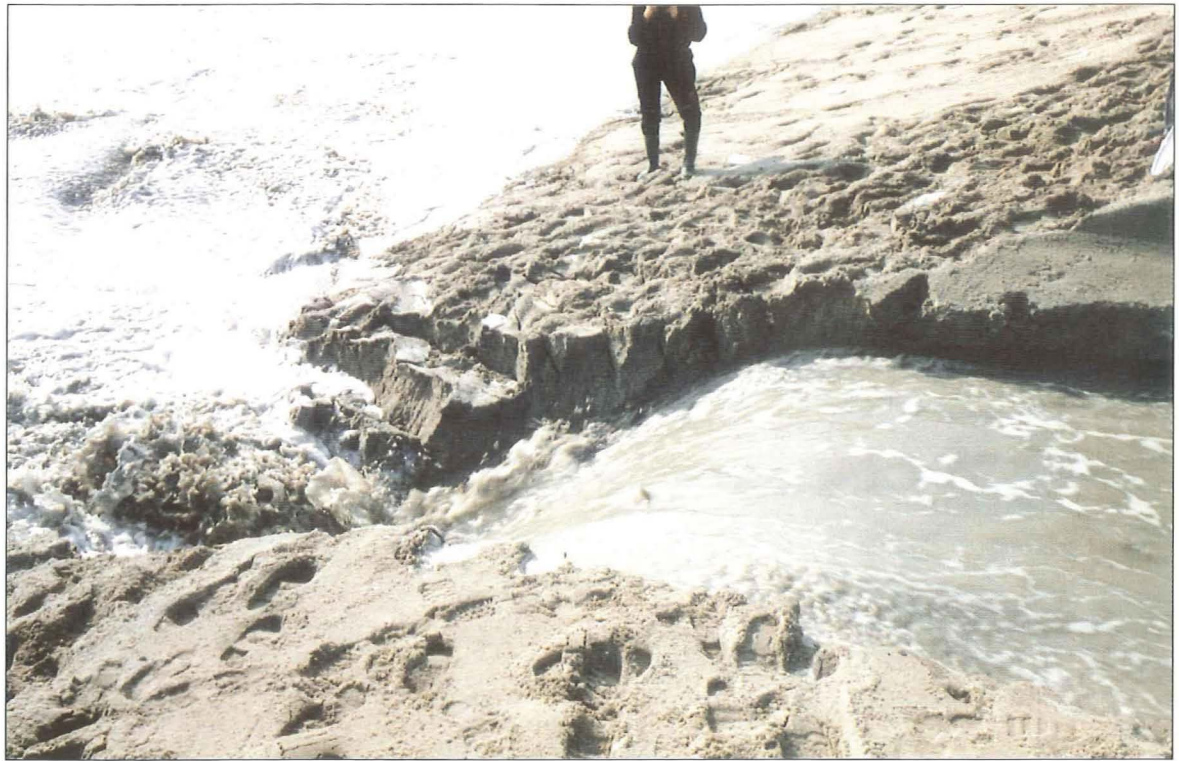
Figuur 3 Versteiling van het binnentalud tijdens fase 1
