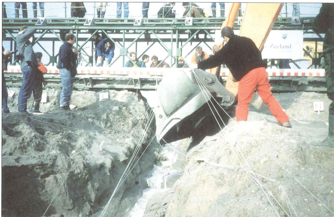
Figuur 12 Initiële geul wordt alsnog verdiept
