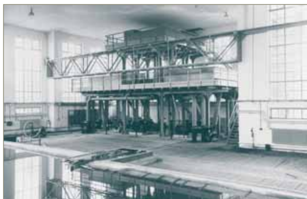
figuur 17: Foto pompinstallatie hal 2 na bouw
