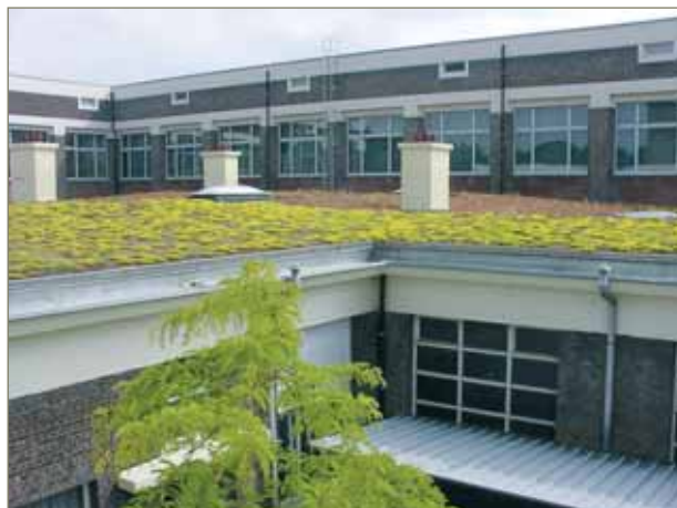
figuur 12: Zicht op het groendak
