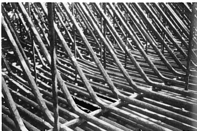
Figuur 7. Onderwapening pijlervloer, staven ø 50 mm.
