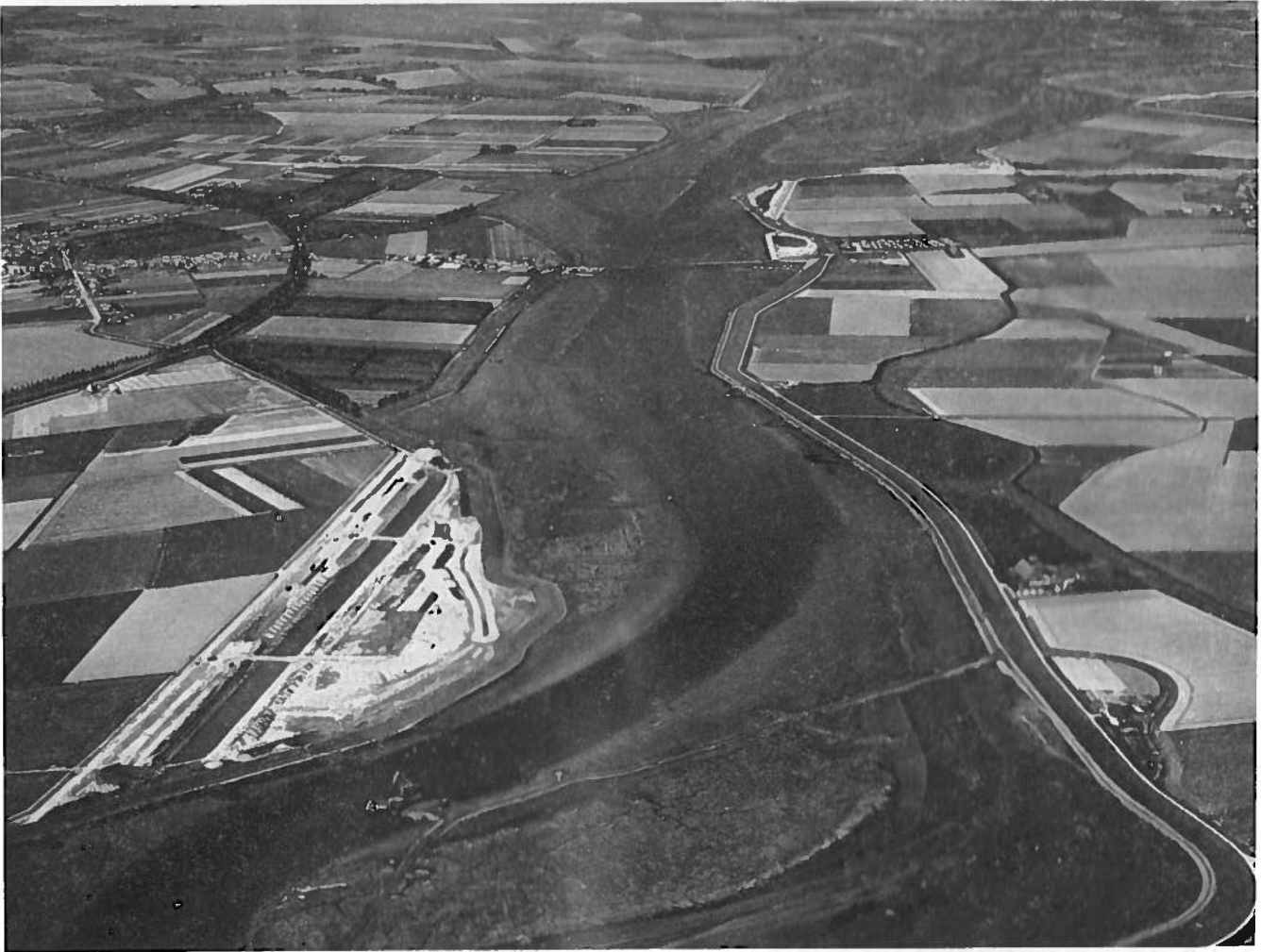
Figuur 76 geeft een totaaloverzicht van het werkgebied van het bestek BER 1065. Links onderaan de dijksnijding in de Leguitpolder (zie ook fig. 64). Rechts onderaan de omkading in aanleg van het depot III. Even boven het midden van de foto de thans vervallen pontoonverbinding tussen Oud-Vossemeer (eiland Tholen) en Nieuw-Vossemeer (Noord-Brabant). Daarboven aan de Brabantse zijde de dijksnijding in de Becinspolder met ten noorden daarvan de aanleg van de opritten voor de brugverbinding bij Vossemeer en de eerste werkzaamheden voor de aanleg van de grondbergingen I en II.
