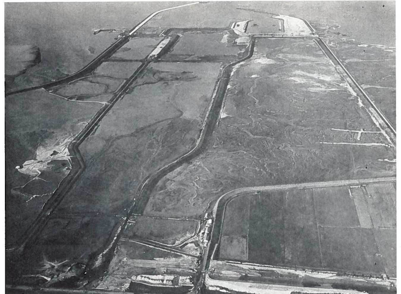
Figuur 48. Overzicht stand van het werk dd. 23-12-1968 gezien vanuit het zuiden.
