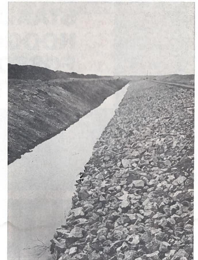
Figuur 57. Taludbestorting op kraagstuk.
