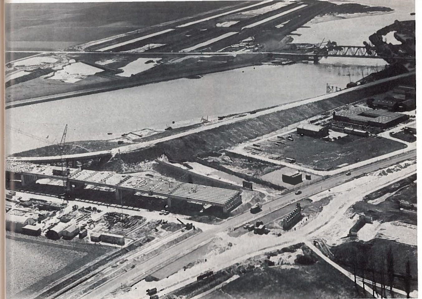
Figuur 60. Overzicht bouw westelijke viaducten. Op de voorgrond is de in aanleg zijnde baanverdubbeling in de prov. weg Tholen - Oud-Vossemeer te zien, met de in aanbouw zijnde pijler no. 1 in de tussenberm. Voorjaar 1970. (foto Wim Riemens M'burg)
