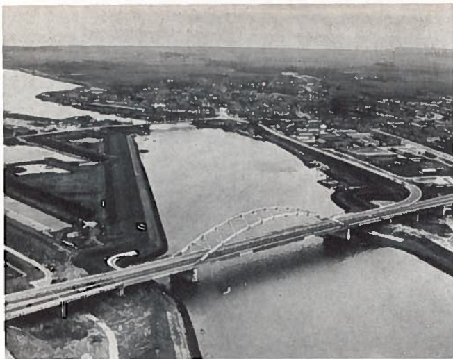
Figuur 62. Overzicht van de in gebruik genomen brug (februari 1971), met op de achtergrond de oude brug. (foto Wim Riemens M'burg)
