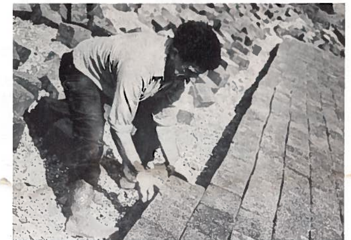
Figuur 61. Het aanbrengen van de glooiing van koperslakblokken. (foto H. A. van Oord Izn.)
