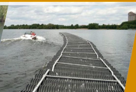
Des brise-lames flottants constitués de tubes en plastique peuvent être utilisés pour protéger les côtes des vagues de battillage créées par les navires de plaisance (Crédits Kuznetsov).
