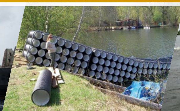
Des brise-lames flottants constitués de tubes en plastique peuvent être utilisés pour protéger les côtes des vagues de battillage créées par les navires de plaisance (Crédits Kuznetsov).
