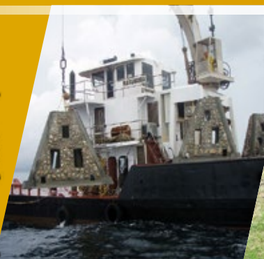
Des bioblocs peuvent être incorporés aux ouvrages de protection traditionnels pour accroître la biodiversité. (Crédits David Thomas Université de Bangor)
