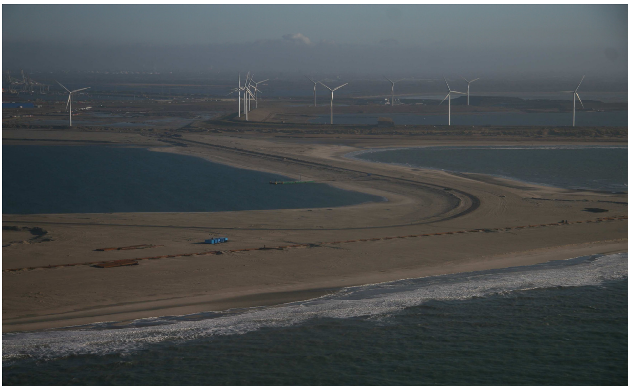
Aanleg Tweede Maasvlakte, 17 januari 2010 (foto: Pim Wolf).
