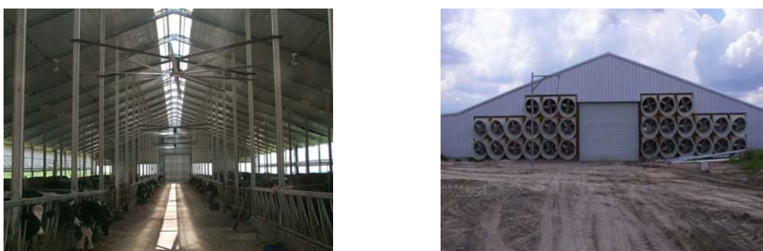
Figuur 20 Links: HVLS-ventilatoren in melkveestal (© ID Agro); Rechts: Tunnelgeventileerde melkveestal (Bray et al., 2003)
