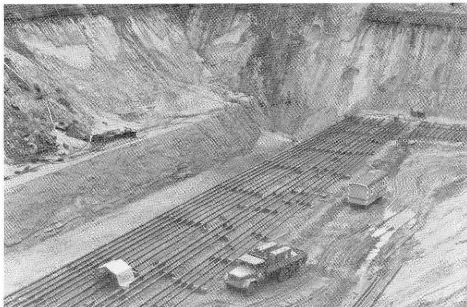
FIG. 4 Omlegging van nutsleidingen en industriële leidingen.
