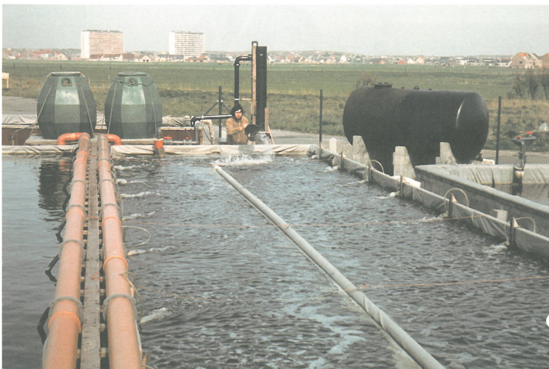
Jan Verboven (RUG) inspecteert de wierbekkens aan de Spuikom in 1978
