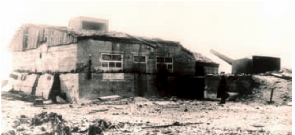
■ Die Batterie Oldenburg kann als Beispiel für eine gute Tarnung gelten. Hier sehen wir einen der Bunker, der als Bauernhof getarnt wurde. Auf den Beton hat man Türen und Fenster gemalt und darüber ein Satteldach errichtet. Rechts auf dem Foto ist eines der Geschütze zu sehen. (CDH Evere, Foto Massot)
