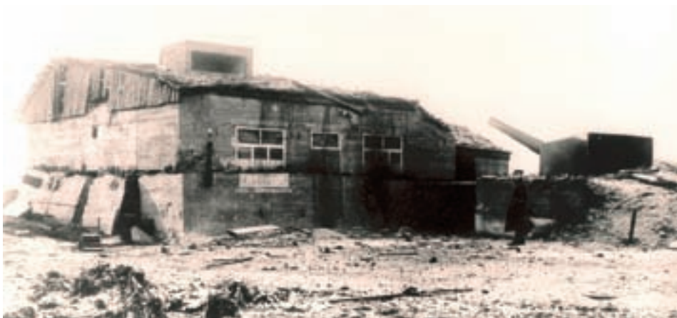
■ La batterie Oldenburg est un bon exemple de camouflage efficace. Nous voyons ici l'un des bunkers camouflés en ferme. Des portes et fenêtres avaient été peintes sur le béton et un toit en bâtière avait été construit au-dessus du bunker. On peut voir l'une des pièces d'artillerie à droite (CDH Evere, Photo Massot)
