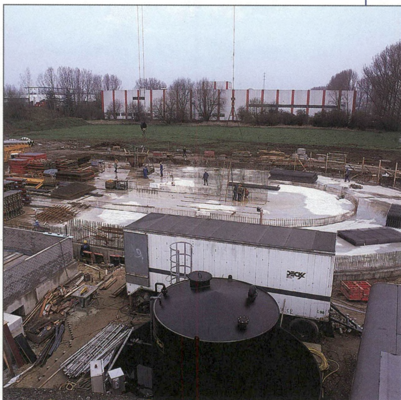
RWZI IN AANBOUW - TIENEN
