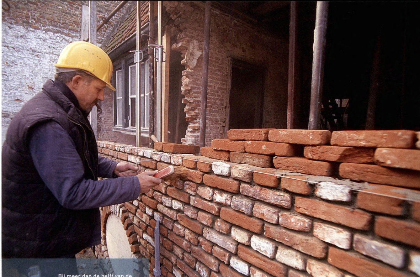
Bij meer dan de helft van de bouwvergunningen ging het om renovatie.
